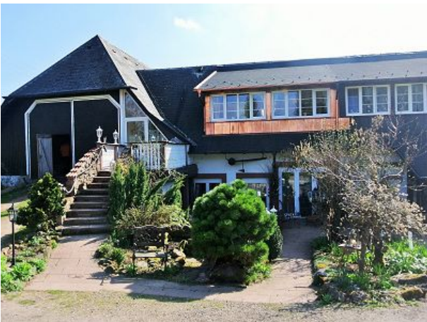
Außenansicht mit Eingang unten
