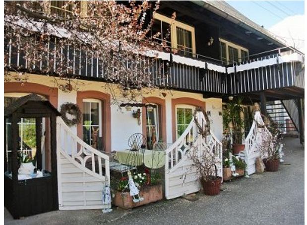
Balkon Freisitz teils überdacht
